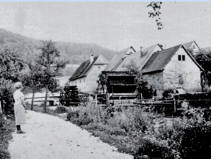
7 Wasseräder in Ebermannstadt: im Vordergrund für den Maschinenantrieb der Schmiedewerkstatt Rudolf Göller – im Hintergrund das Wasserschopfrad nach 1932 (Archiv: Christian Rösch)
