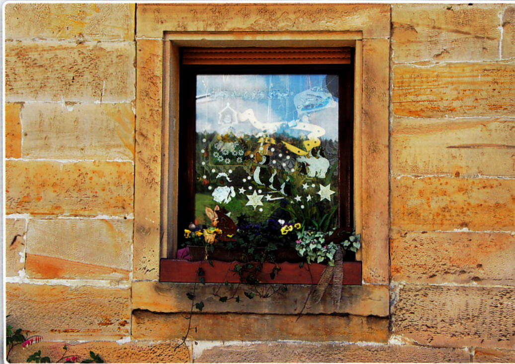
Bild ❸ Eisensandsteinbauweise (Körzendorf). (Foto: W. Schirmer 10.05.2015)
