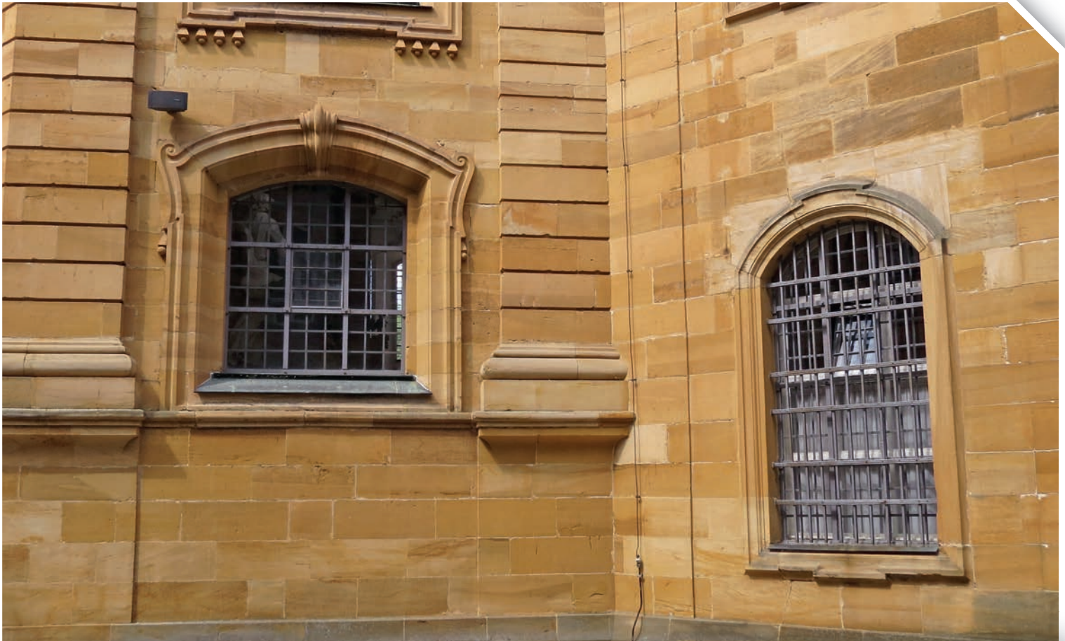
Bild 6: Südostecke der Kirche Vierzehneiligen. Rechts ein Sakristeifenster mit Architektur Krohnes, links ein Kirchenfenster mit Architektur Neumanns. Bleibt allerdings offen, ob Krohne das Aussehen von Sakristei und Kirche vielleicht auch unterschiedlich halten wollte. – Über dem rechten Fenster neu eingesetzte hellere Reparatursteine.
