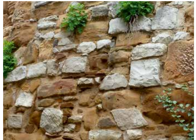
Abb. 13 Stadtmauer in Bad Staffelstein, erbaut aus weißem Werkkalk und gelbbraunem Eisensandstein. (Aufnahme v. 1. Mai 2013; W. Schirmer)
