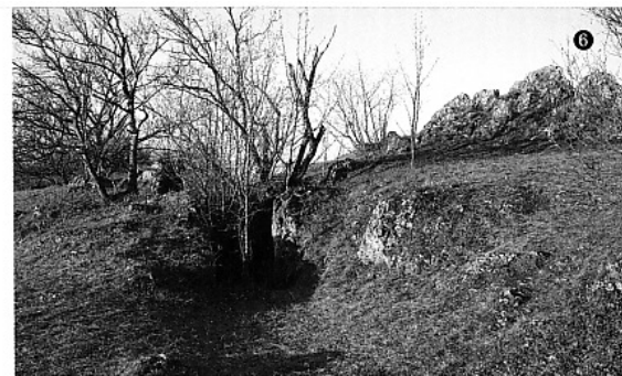
Gelände- und Felspalte hinter dem Ehrenbach-Kopf (Massendolomit). Die Spalte ist der Beginn des Abrisses einer weiteren Felsplatte des Ehrenbach-Kopfes. – Foto: 26. Dezember 2006 Photos: Verfasser
