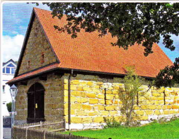
Bild 4 Gebäude in Pretzfeld aus goldbraunem Eisensandstein (Dogger \beta ) erbaut mit Sockel aus weißem Werkkalk (Malm \beta ) zum Schutz vor Feuchtheitsaufstieg.
